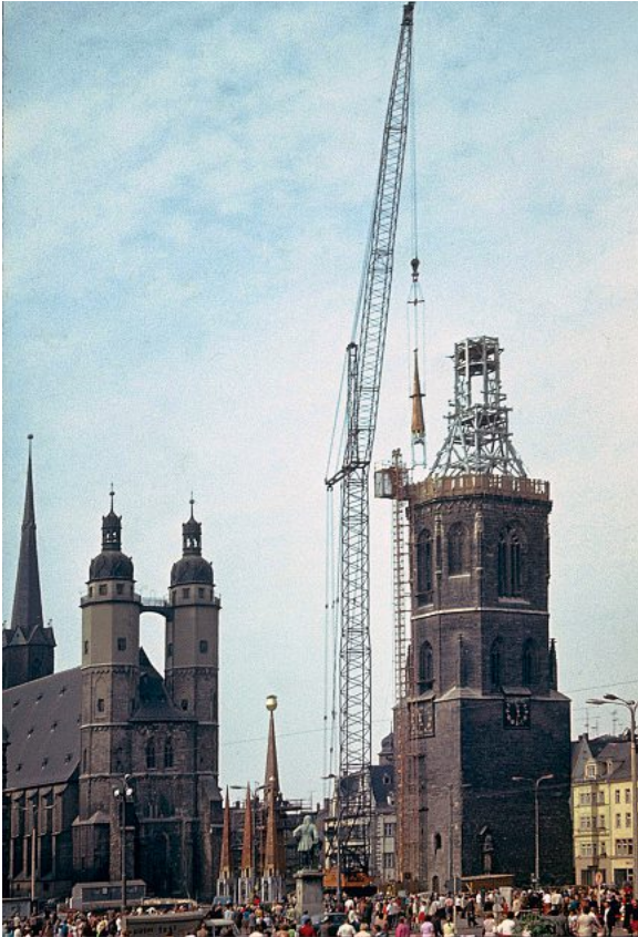
Der Rote Turm mit dem Montagekran Anfang September 1975
